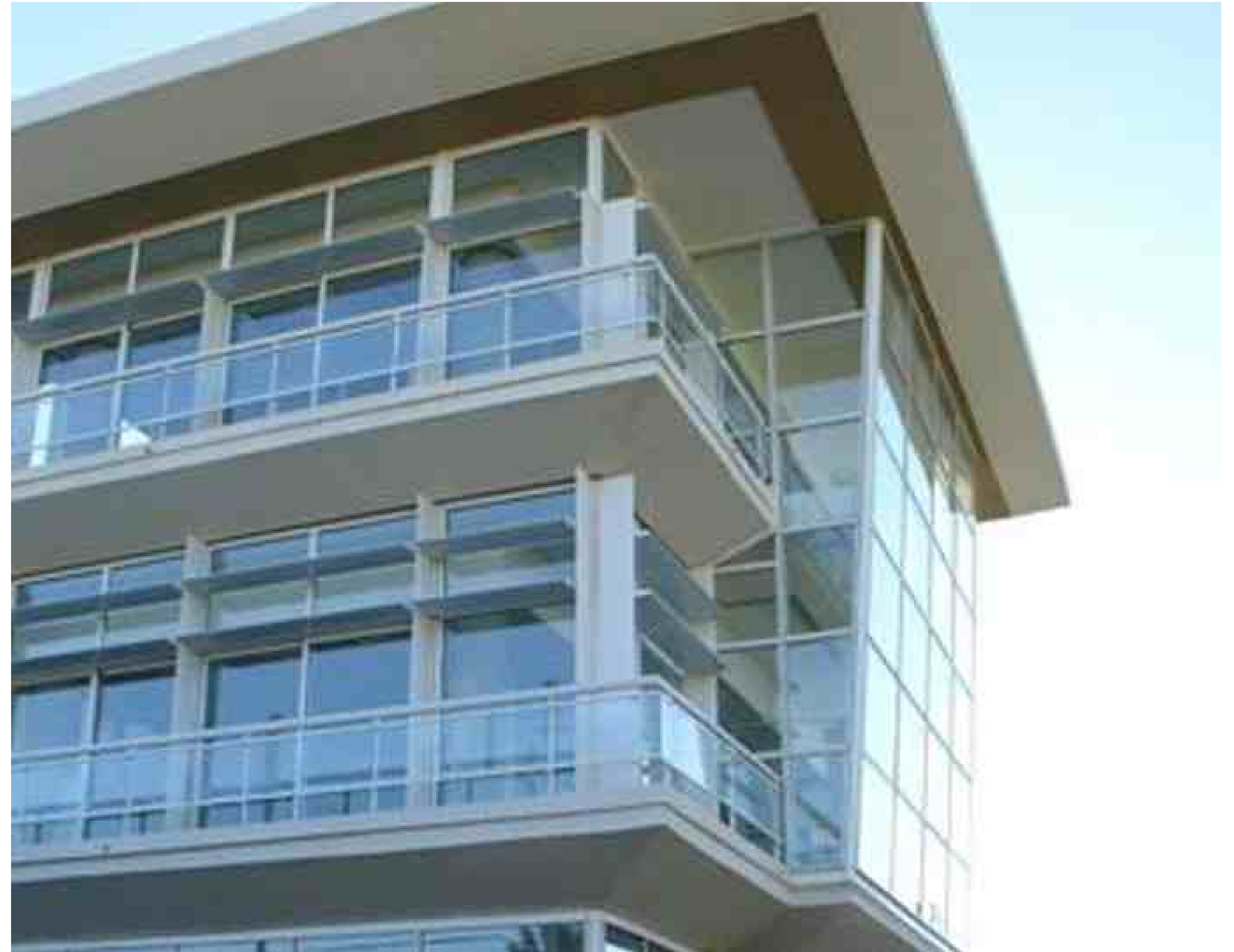
ARRIBA: Edificio Vialidad Nacional
